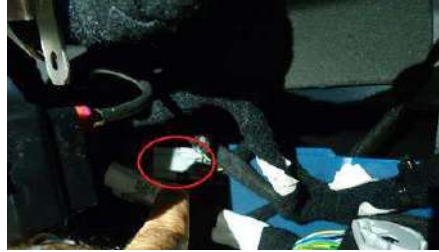
Tavan Üstyapı Elektrik Konnektörü
