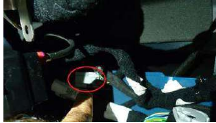
Tavan Üstyapı Elektrik Konnektörü
